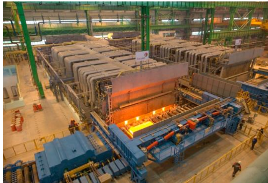
Four de réchauffage
